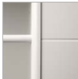
pohled na frézování
