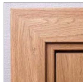
standardní spojování lišt pod úhlem 45°
